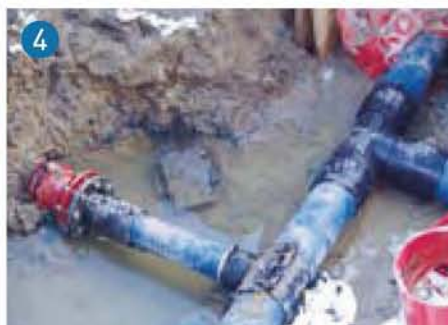
Širok raspon spojnice za pouzdane prijelazne nastavke. MULTI/JOINT 3000 nudi veliku otpornost na krajnje opterećenje bez popratnih udara.
