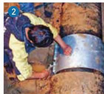
Sve vrste materijala za cijevi. Za popravke pri tlaku do 20 bara.
