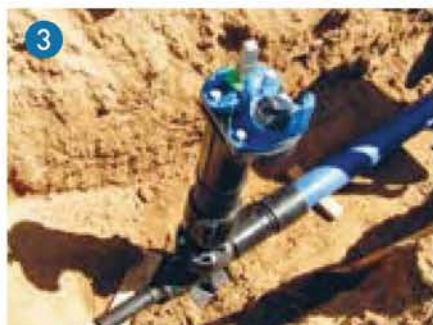
Novi PE-hidrant. Inovativni se polietilenski hidrant može spojiti različitim tipovima priključaka.
