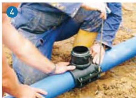
Priključak na plastični cjevovod vertikalno ili bočno. Širok raspon spojnica koje zadovoljavaju sve zahtjeve.
