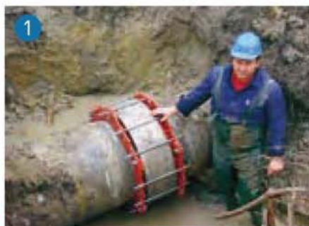
Popravak spojnica koje cure pod pritiskom. WAL/V-obujmice za cijevi koje cure pružaju pouzdano rješenje za popravak.
