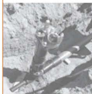
Hidranti i priključci
