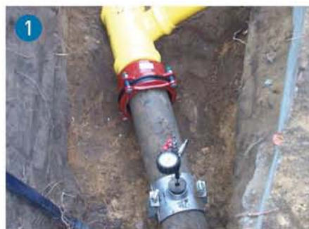
Brzo zatvaranje dovoda plina korištenjem Multi/Clamp-obujmice s balonom.
