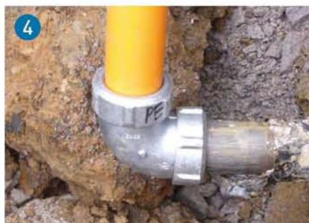
Brzi prijelaz s PE100 na postojeću čeličnu cijev priključnoga plinovoda obavlja se Primofitom.
