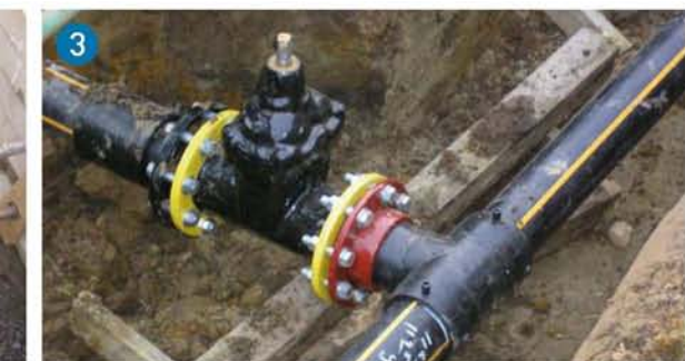
Jednostavna tehnologija instalacije. PE-mjesto račvanja cjevovoda s priključkom Draw Lock s priрубnicom.
