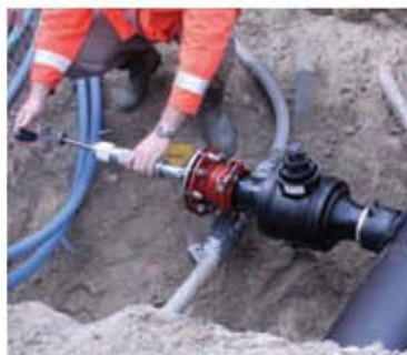
W410-bušilica za bušenje cijevi pod tlakom kroz Polyvalve i ELGEF Plus Saturn-sedlo.
