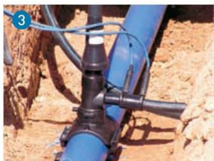
Ventili za cijevi. Dugotrajni, možete odabrati jednu od dvije raspoložive izvedbe za cijevi i izlaz koji se može zakretati za 360°.
