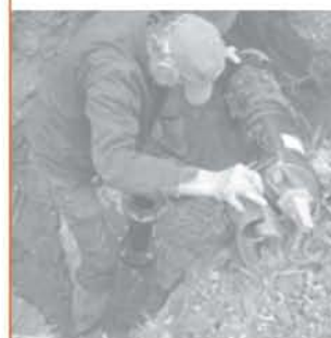
Hidranti i priključci
