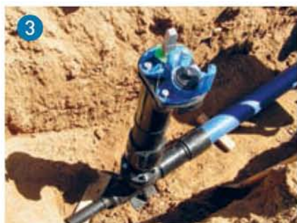
Novi PE-hidrant. Inovativni PE-hidrant se može spojiti korištenjem različitih tipova priključaka.
