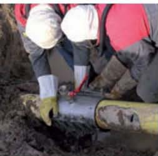
Multi/Clamp-obujmice od nehrđajućega čelika za popravak cijevi u hitnim slučajevima i pod tlakom.
