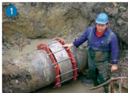
Popravak spojnica koje cure pod pritiskom.
