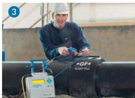
Automatski unos podataka o spajanju. Jednostavan i brz unos potrebnih podataka o spajanju sa čitačem barkoda.
