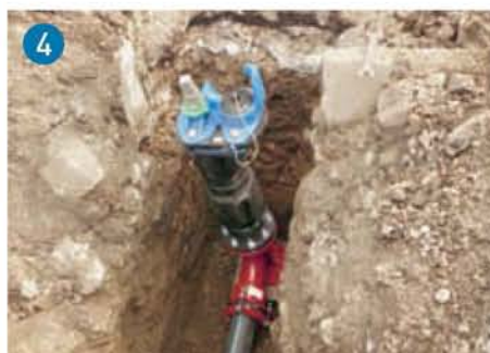
Brzo i jednostavno priključenje korištenjem MULTI/JOINT N-komada za sve materijale cijevi i hidrante.
