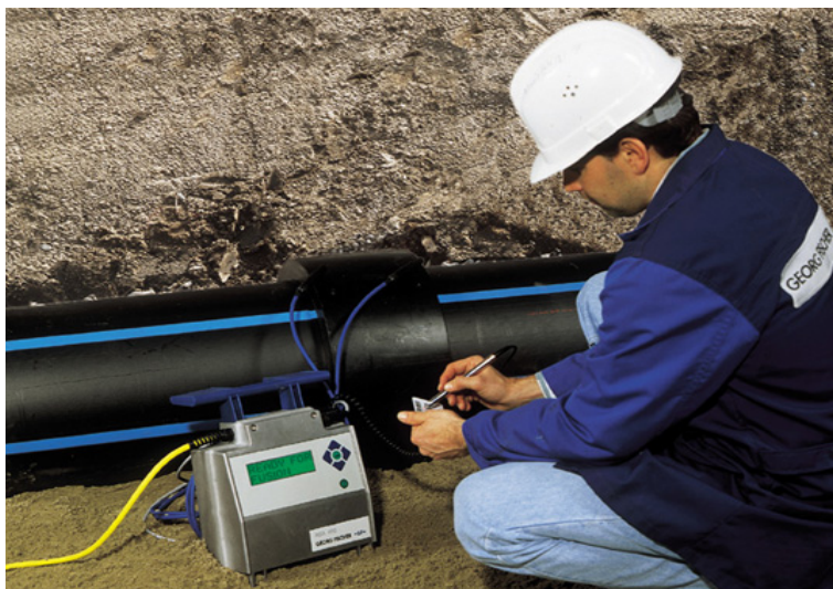
Slika 1 – Postupak elektrofuzijskog zavarivanja
