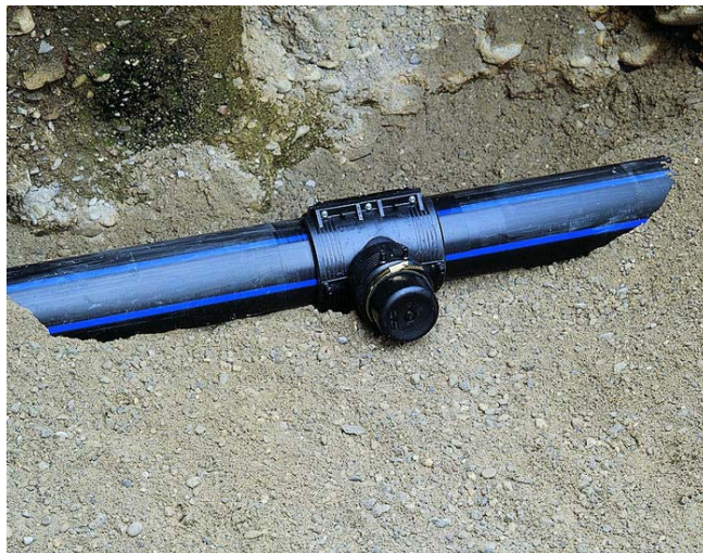
Popravak oštećenja na cjevovodu
