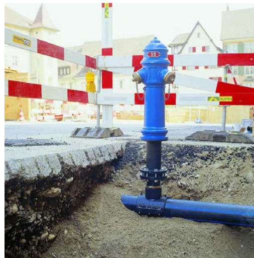
Montaža hidranta
