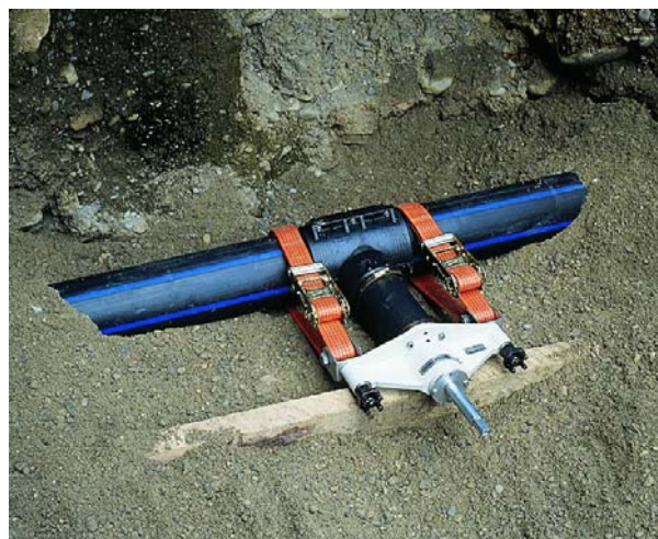
Slika 5 Izrada priključnih ogranaka kod novih cjevovoda
