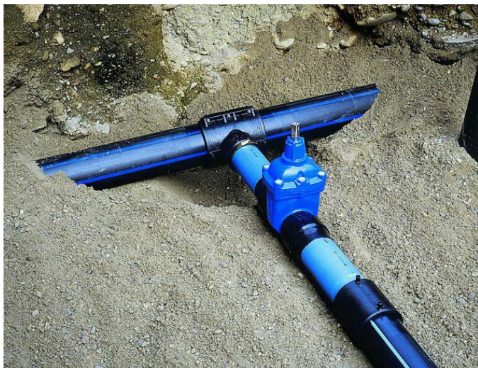
Montaža zasuna sa PE nastavcima
