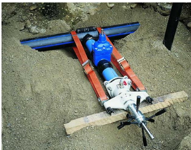
Slika 4 Izrada priključnih ogranaka pod tlakom
