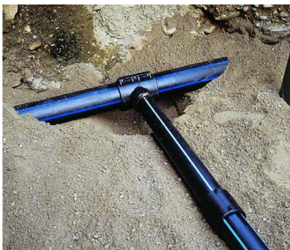
Izrada novog priključnog ogranaka
